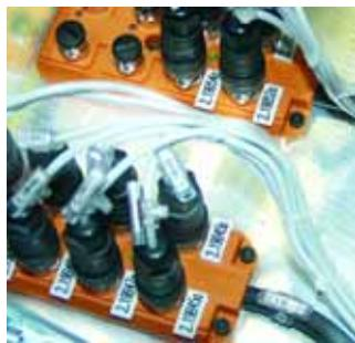
enorme Kosten- und Zeitvorteile gegenüber der Unterverteilervariante, denn die Installation von Reihenklemmen in den Verteiler, sowie der Einbau von Kabelverschraubungen entfällt. Die Vorbereitung der Leitungs-Enden, wie Abisolieren und Anbringen von Aderendhülsen, ist nicht nötig, da mit vorkonfektionierten Leitungen gearbeitet werden
